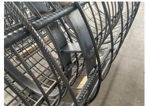
VERBINDUNG INNERER MIT ÄUSSERER AUSSTEIFUNGSRING PER DISTANZSTÜCK
