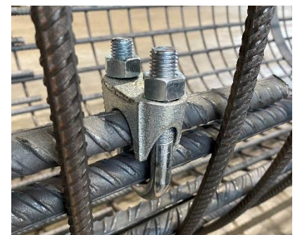
VERBINDUNG MITTELS SEILKLEMMEN
